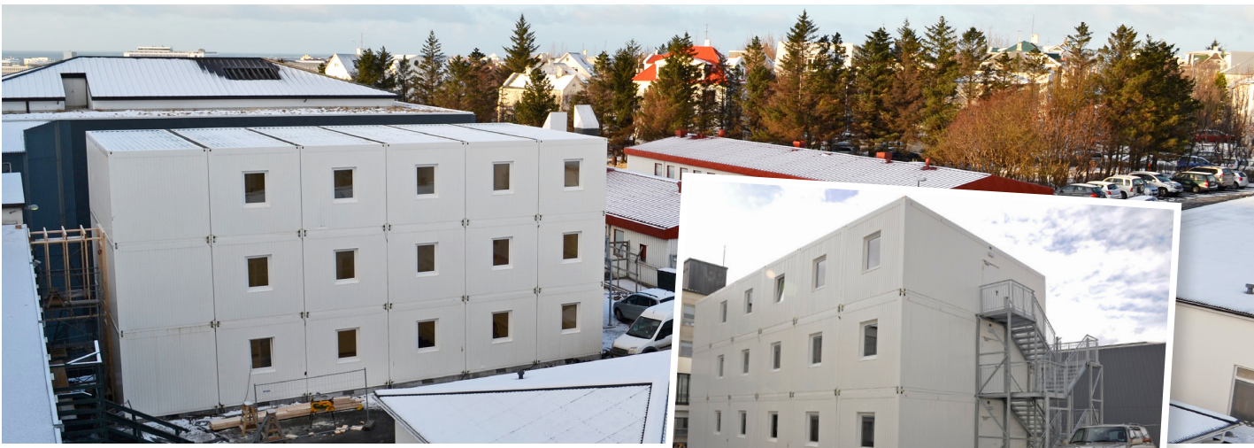
Skrifstofur lækna við Landsspítalann við Hringbraut.
